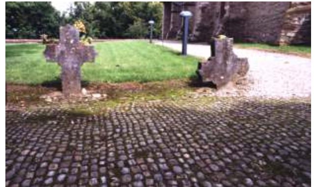
Abb.2: Pflaster aus Brennringen vor der „Alten Kirche“
