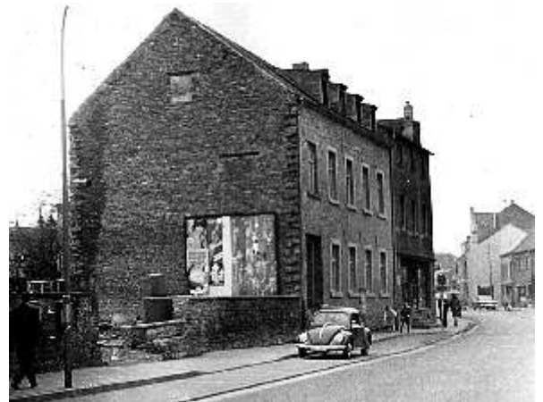
Abb. 10 Von der Kirche auf dem Rymelsberg zieht die Museumsammlung 1929 in die Knabenschule um. Blick von der Hauptstraße auf das Schulgebäude. In den 1960er Jahren wird es abgerissen. Foto bei Norbert Breuer, Langerwehe
