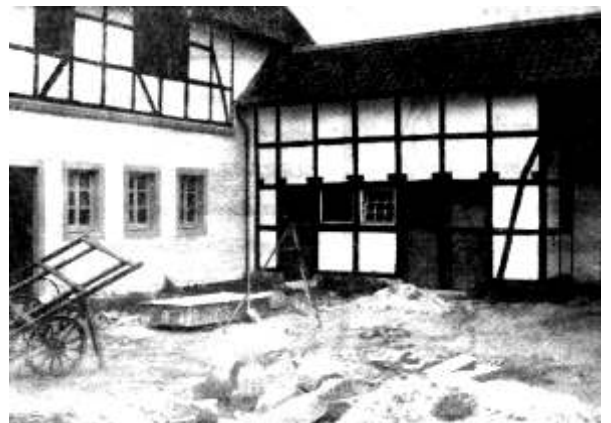
Abb. 46 Baumaterialien vor der Töpferwerkstatt mit darüber liegender Wohnung ( 2. Bauabschnitt ). Foto aus der Dürener Zeitung vom 3. 9. 1956.
