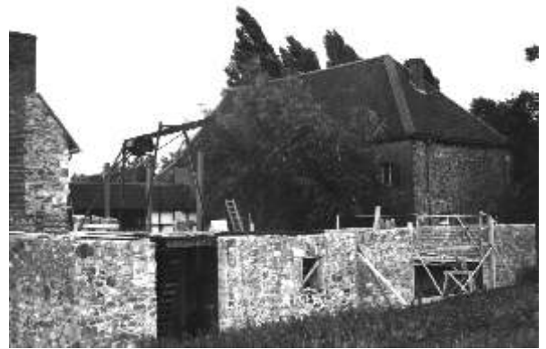
Abb. 47 1955 beginnen die Arbeiten am 3. Bauabschnitt. Aufnahme Willi Mock. Foto Archiv Töpfermuseum.
